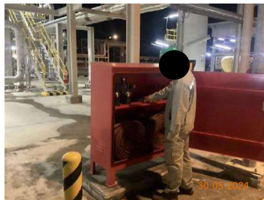
รูปที่ 3-58 อุปกรณ์ดับเพลิงและตัวอย่างการตรวจสอบถังดับเพลิงประจำเดือน
