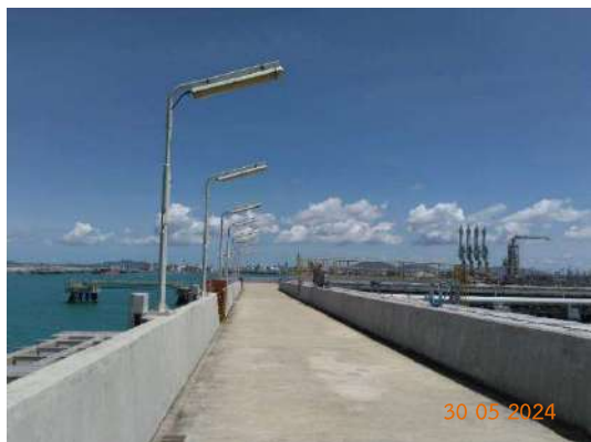
รูปที่ 3-44 ระบบไฟฟ้าแสงสว่าง และหุ่นไฟจราจรแสดงขอบเขตท่าเทียบเรือ
