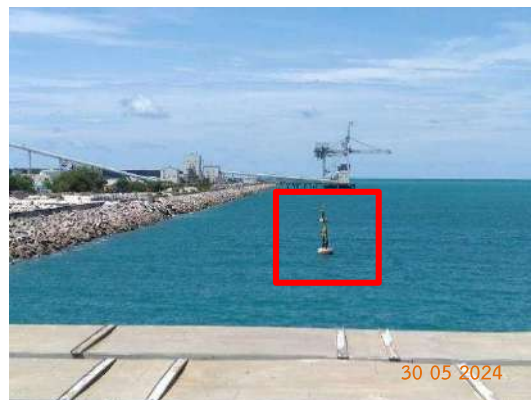
รูปที่ 3-44 ระบบไฟฟ้าแสงสว่าง และหุ่นไฟจราจรแสดงขอบเขตท่าเทียบเรือ
