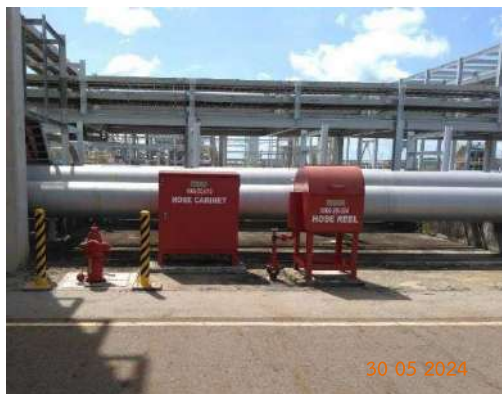
รูปที่ 3-58 อุปกรณ์ดับเพลิงและตัวอย่างการตรวจสอบถังดับเพลิงประจำเดือน
